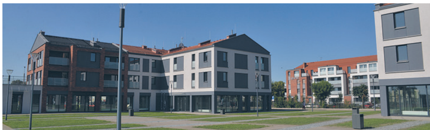
W miejscu dawnej bazy PKS-u stanęło już kilka nowoczesnych obiektów mieszkalnych, budowane są jeszcze trzy kolejne
