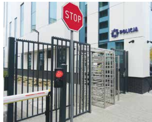
Nowe laboratorium kryminalistyczne policji powstało na poznańskich Jeżycach przy ul. Kochanowskiego.
