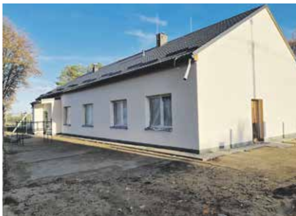
I miejsce w kategorii „Zurbanizowana Wielkopolska” zajął kadr pokazujący „Przebudowę budynku użyteczności publicznej na Ośrodek Edukacji Ekologicznej w Rychliku”.
