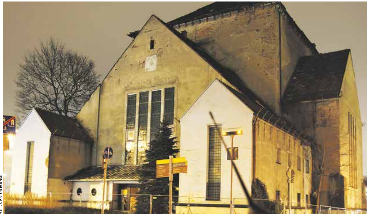
W takim stanie znajduje się obecnie gmach, w którym na początku XX wieku mieściła się poznańska synagoga, następnie przebudowany przez Niemców na pływalnię miejską i w tym charakterze użytkowany także przez kilka powojennych dekad.
