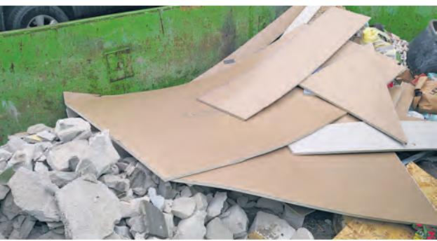
Odpady budowlane powstające podczas prac remontowych przeprowadzanych w naszych mieszkańach stanowią cenny surowiec wtórny. Głównym ich składnikiem jest gruz betonowy i ceglany. Materiały te po prostym przetworzeniu stanowią pełnowartościowe kruszywo budowlane, które może znaleźć zastosowanie zarówno przy produkcji materiałów i elementów budowlanych, jak i podczas budowy obiektów budowlanych i dróg.
